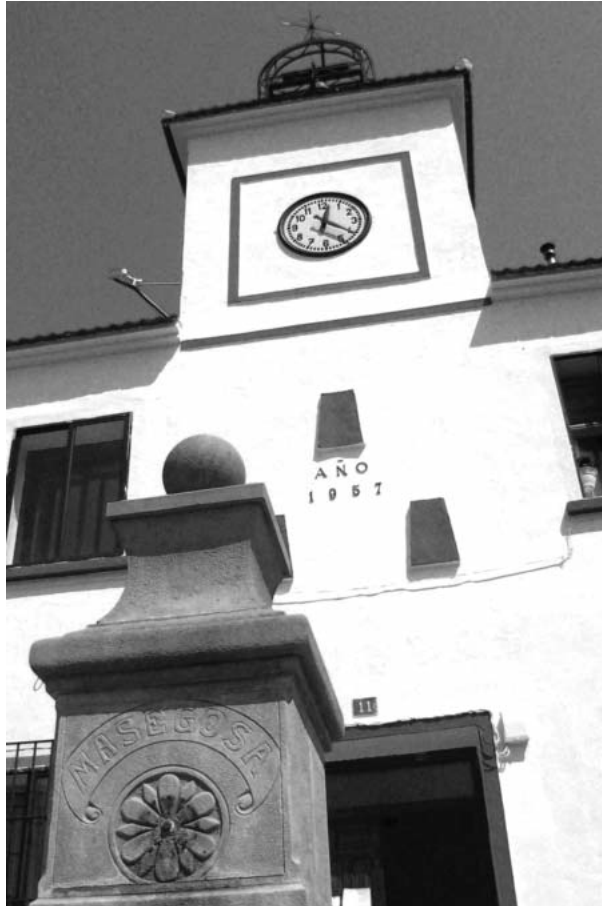
Edificio actual de las antiguas escuelas.
