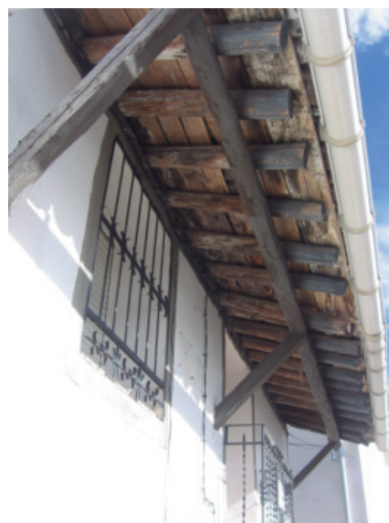
Jácena utilizada para reforzar las vigas de un voladizo en Masegosa.
