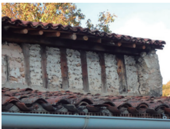
Detalle de fachada en la localidad de Poyatos.
