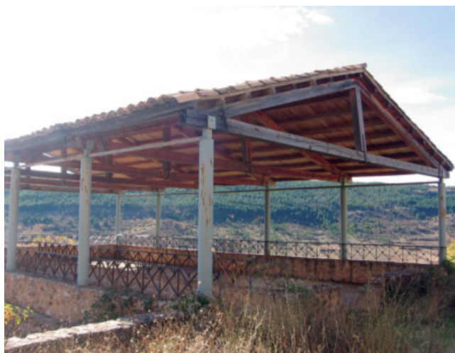
Uso de cerchas castellanas en el mirador de los Hornos de Beteta.
