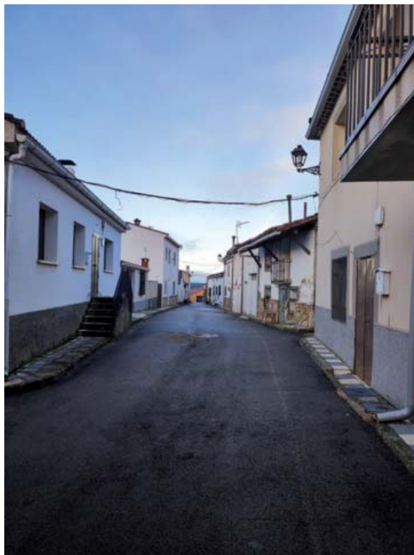
Calle San Quílez, dirección este-oeste. Viviendas formando manzanas alargadas.
