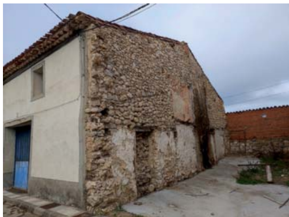
Pared medianera. También puede apreciarse el amplio alero del tejado.
