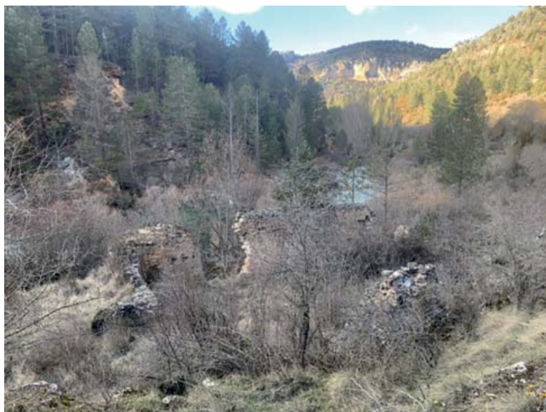
Restos de las instalaciones de la Herrería del Oceseca.
