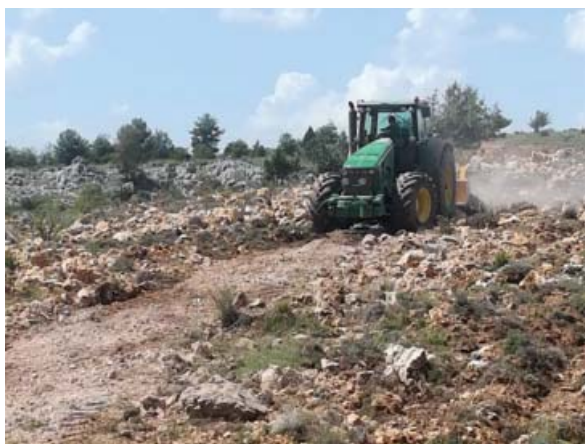
Triturar piedra para preparar el terreno.
