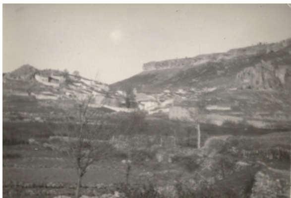
Vista antigua de Cañizares.
